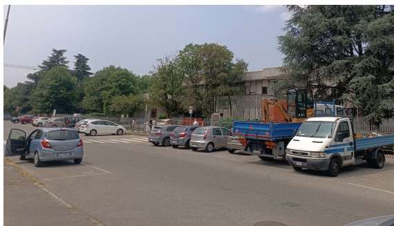
Area intervento da NE
