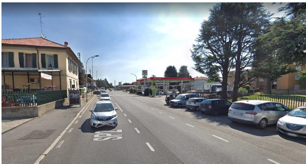
6.8 Immagine stato di fatto esempio A nel tratto urbano
