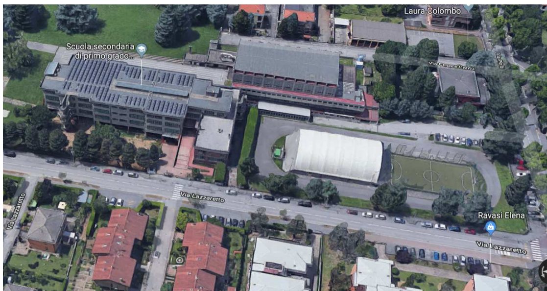
Veduta del complesso scolastico "L. da Vinci"
